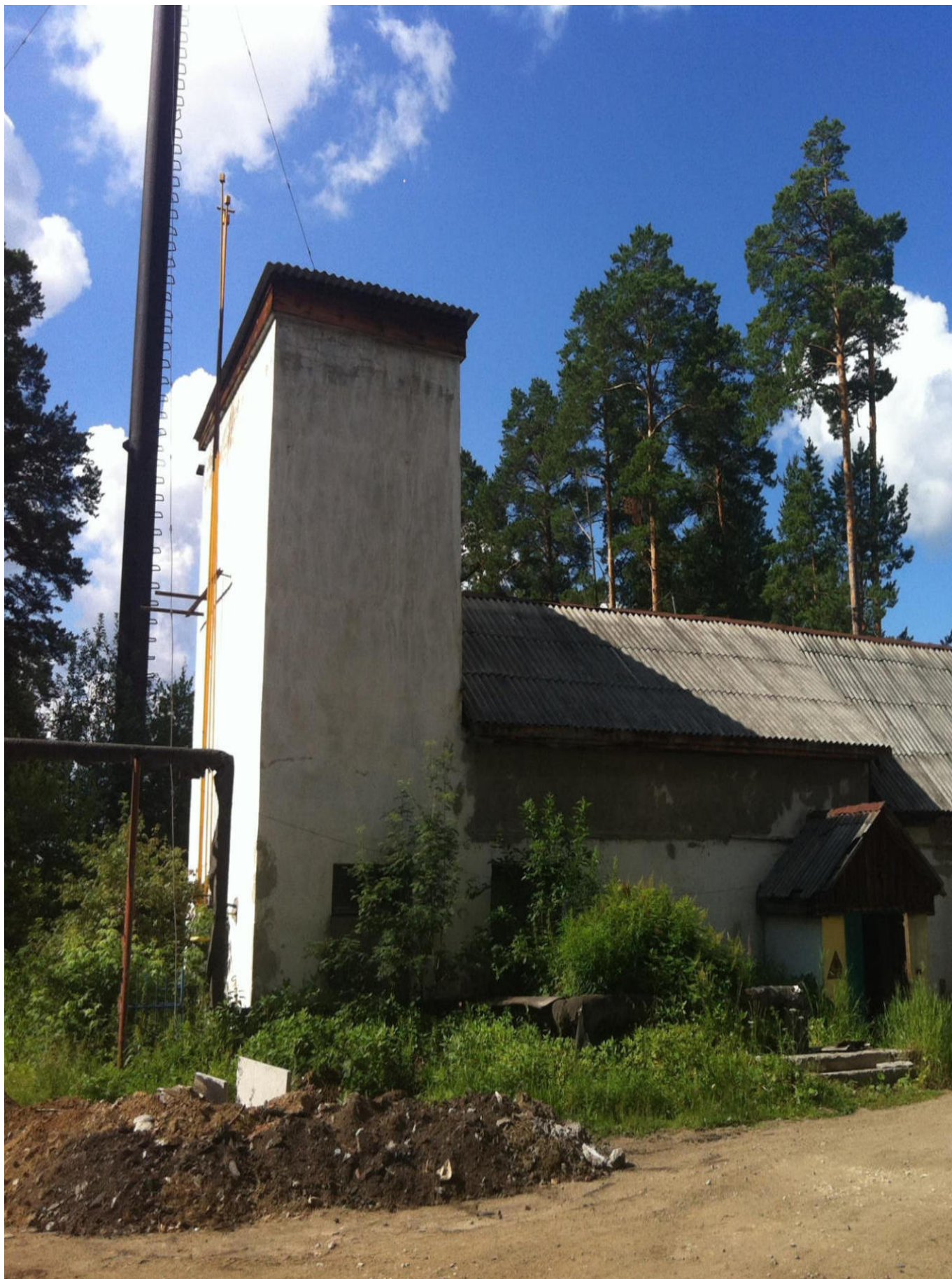
Рис.11. Котельная п. Верхняя Сысерть.
