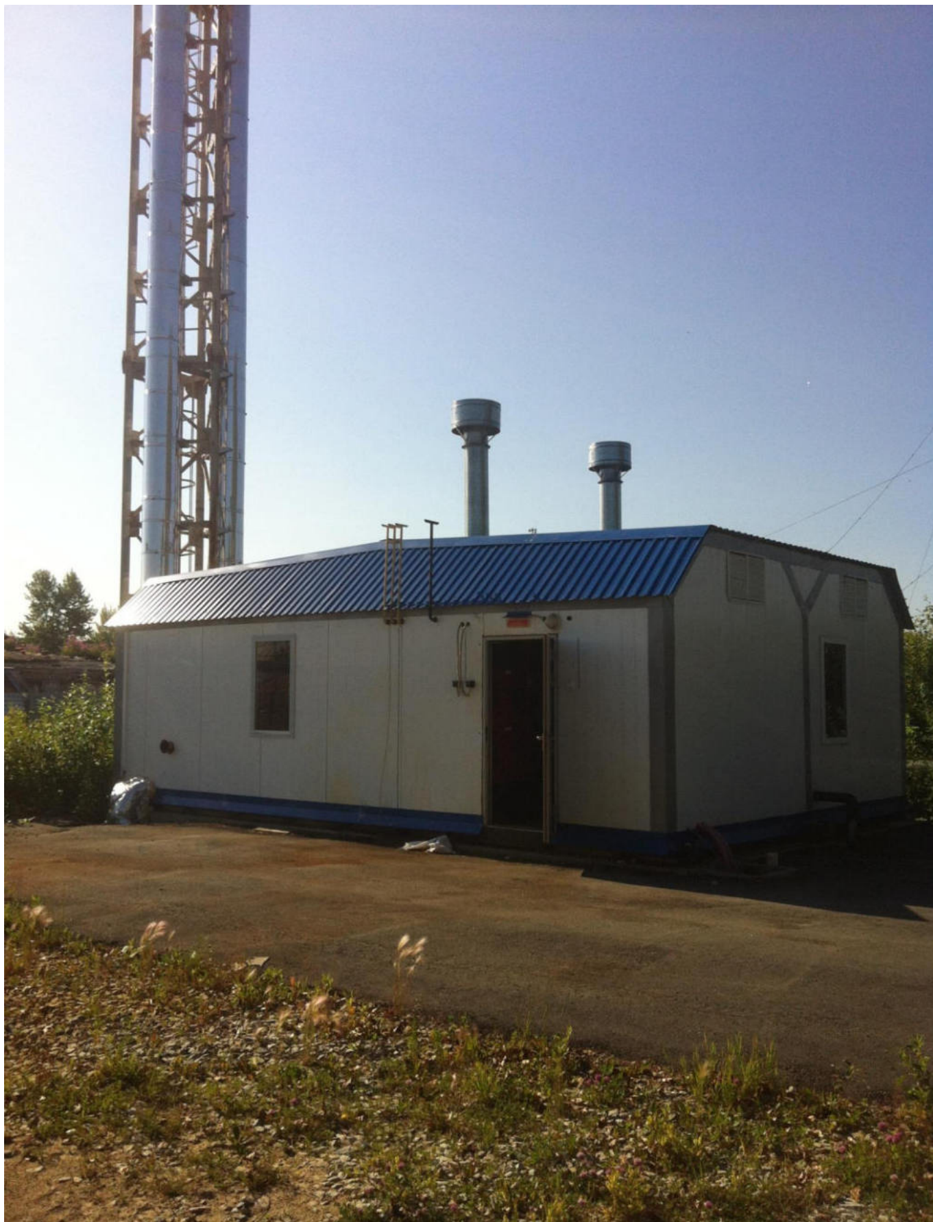
Рис.5. Котельная г. Сысерть (ул. 4-й Пятилетки, 2а).
